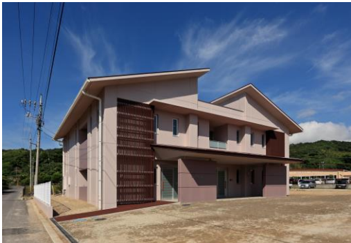
北東面全景（玄関側外観）
